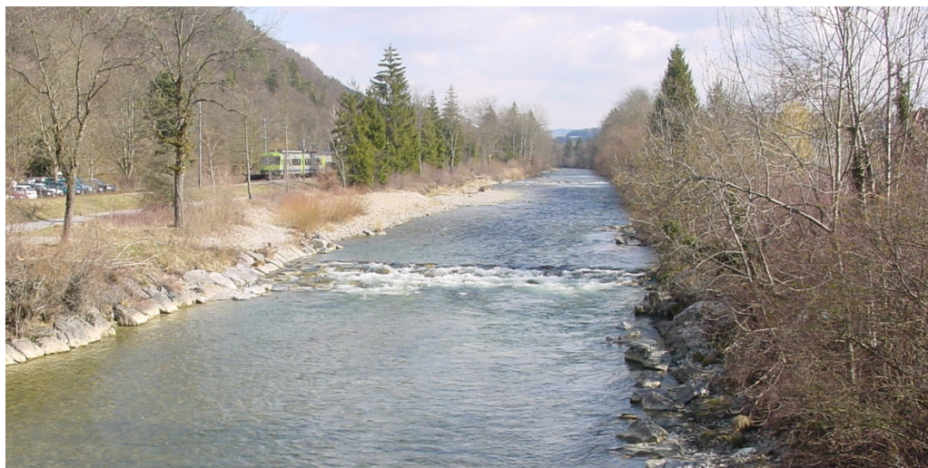
Bild 12: Sense bei Laupen im Zustand vor der Revitalisierung. Aufnahme vom März 2010.
