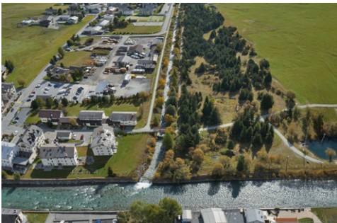
Der Chamuerabach im Ausgangszustand mit Blick flussaufwärts (Aufnahme: P. Rey, Hydra AG)
