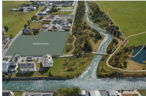
Die Revitalisierung des Chamuerabachs mit Blick flussaufwärts (Visualisierung: P. Rey, Hydra AG)
