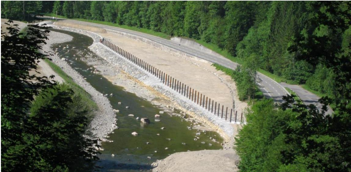
Abb. 3.24 Rechen für den Schwemmholtzrückhalt an der Sihl bei Langnau am Albis (Quelle: AWEL, Sektion Bau).
