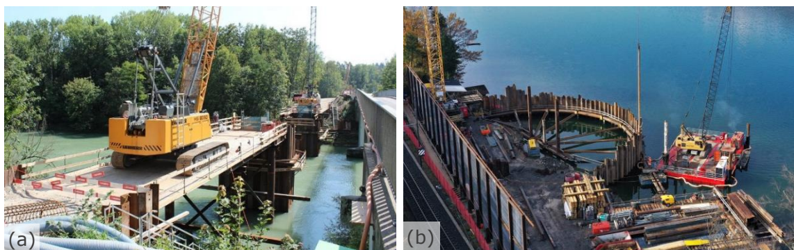
Abb. 3.36 Erstellung der Pfähle (a) von einer Brücke (Quelle: Rothpletz & Lienhard AG) und (b) einem Stelzenponton (Quelle: Meier Jäggi AG).
