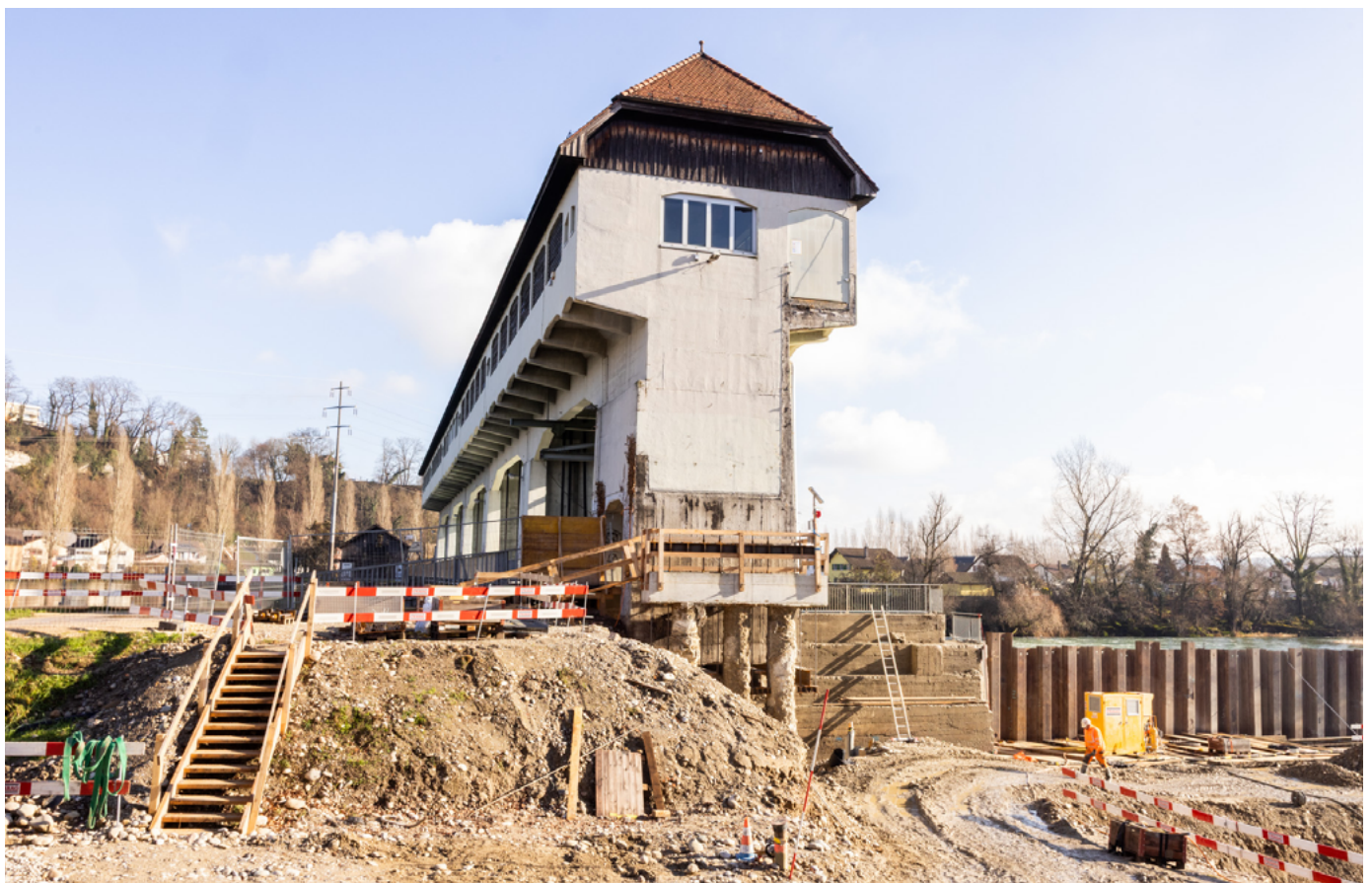
Sanierung des Stauwehrs Winznau des Kraftwerks Gösgen zur Einhaltung aktueller Vorschriften im Bereich Hochwassersicherheit (Foto: F. Basan)
