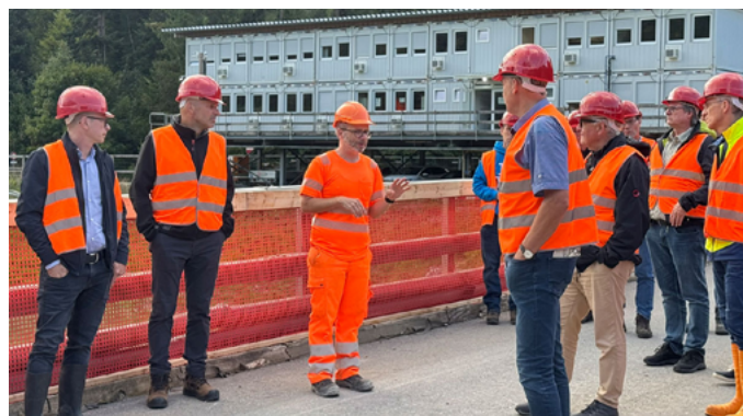
Bauleiter Adrian Stucki über die Komplexität der Baustelle des Entlastungsstollens im Sihltal
